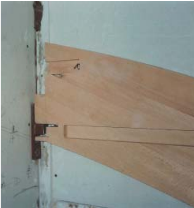
Bild 5: Prototyp eines Eckauflagers zur Lastabtragung über die Außenwange einer Massivholztreppe bei gleichzeitiger Entkoppelung der Wange von der Trennwand
