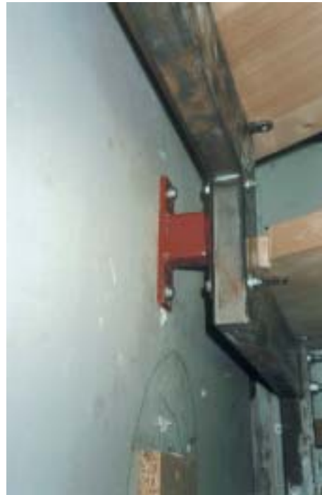
Bild 6: gängiges Auflager zur Lastabtragung bei einer Stahl-Holz-Treppe
