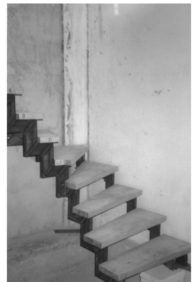
Bild 2: Stahl-Holz-Treppe im Prüfstand
